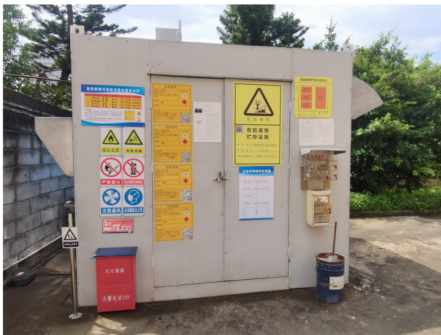
危险废气暂存仓
